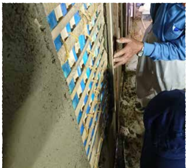
講師の指導を受ける受講生(写真左)、土壁を使った壁づくり(写真右)=雪田の「みんなのふるさと道場」
